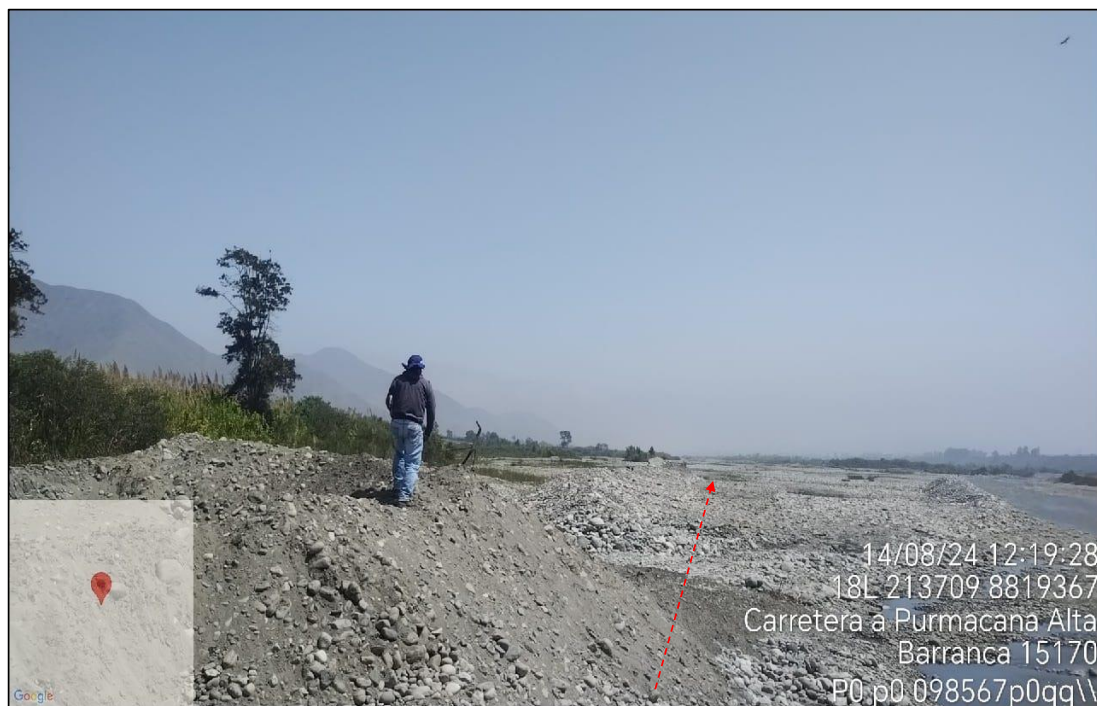
FIGURA N°02: EN LA TEMPORADA DE MAXIMAS AVENIDAS, EL RÍO PATIVILCA SE DESBORDA EN ESTE TRAMO DEL SECTOR ARAYA GRANDE, REQUIERE ENROCADO PARA PORETERGER DE LA EROSION LA MARGEN IZQUIERDA.
